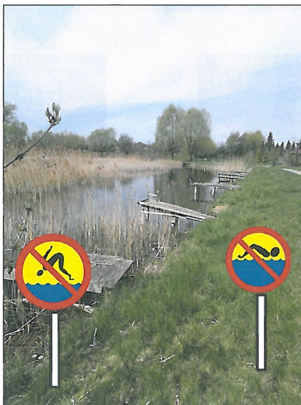
Foto nr 4 – Mosty na terenie Ośrodka „CASUS”
