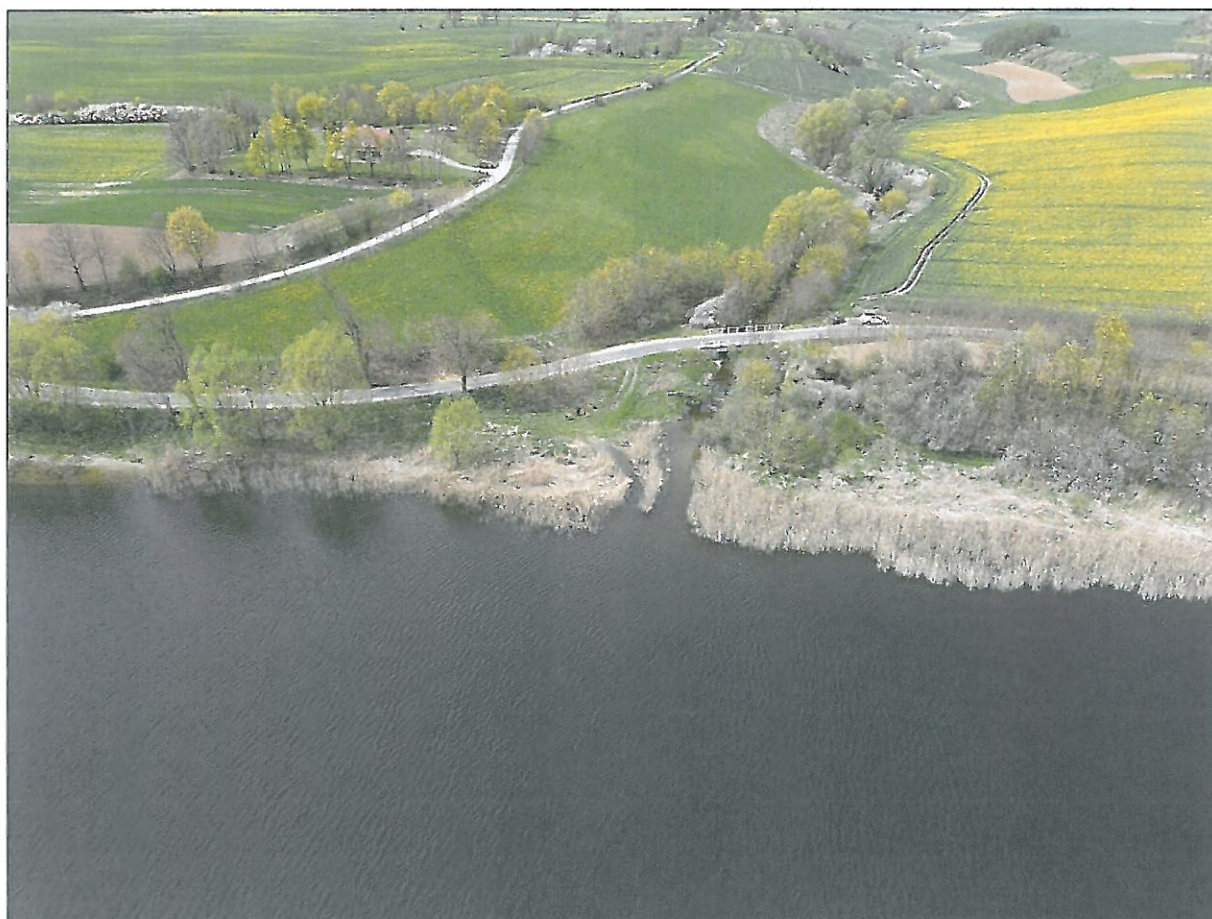
Foto nr 8 – Zdjęcie z lotu ptaka ukazujące ujście rzeki Gardęga do jeziora Nogat – część południowa
