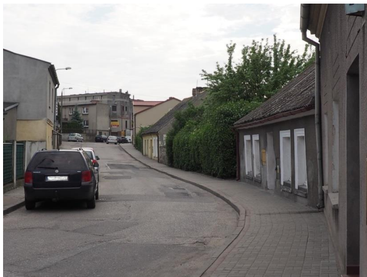
Zdjęcie 1. Przykładowe drogi wymagające modernizacji – ul. Podmurna
