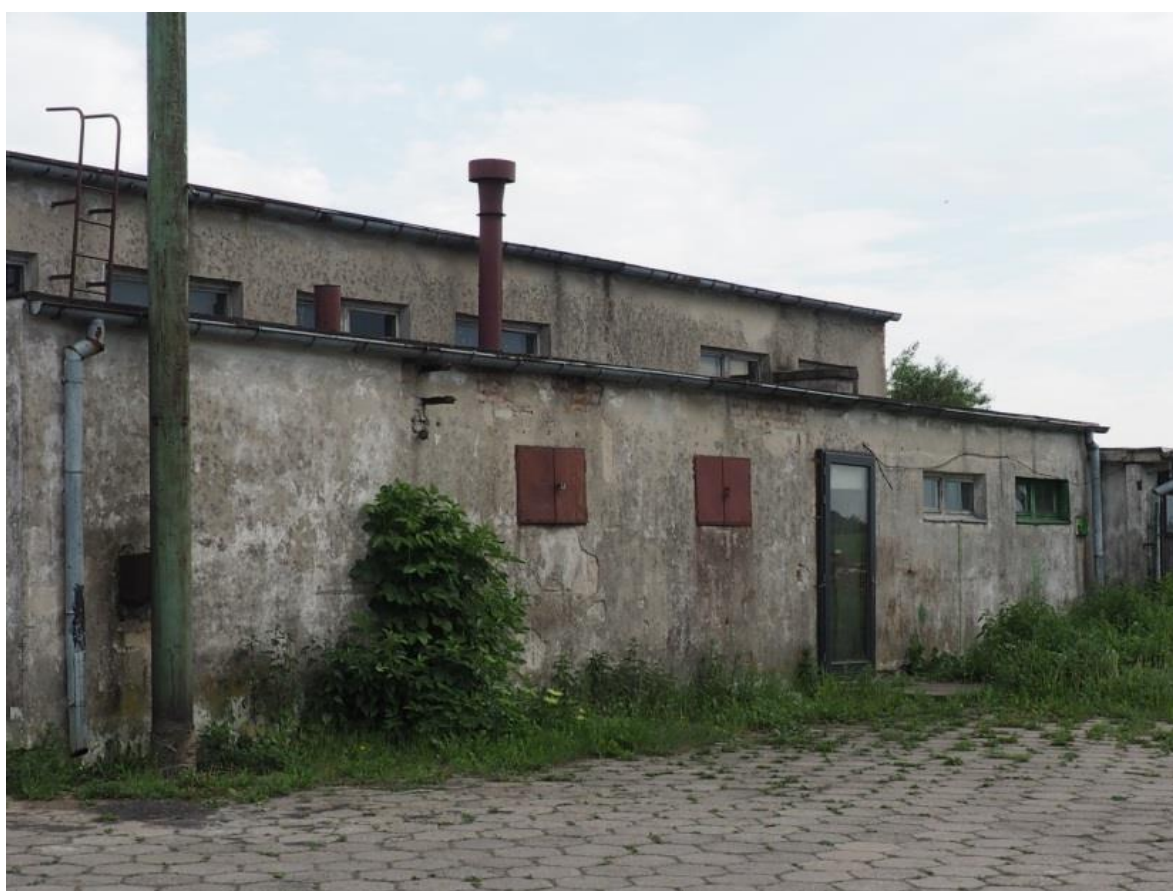
Zdjęcie 5. Przestrzeń zdegradowana – budynek po kotłowni osiedlowej
