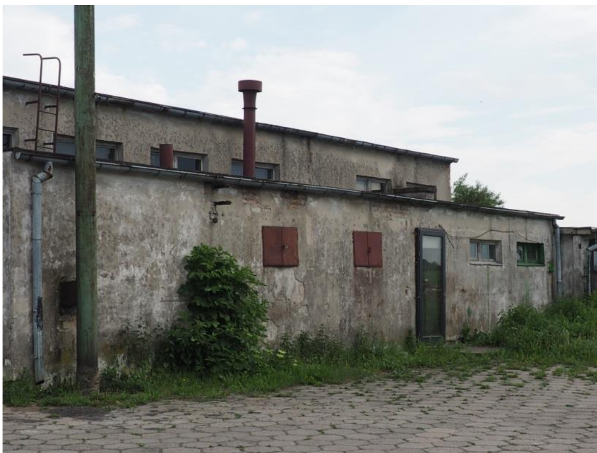
Zdjęcie 5. Przestrzeń zdegradowana – budynek po kotłowni osiedlowej
