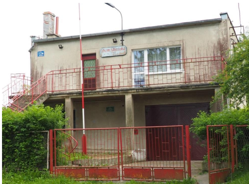
Zdjęcie 3. Świetlica wiejska w Nogacie
