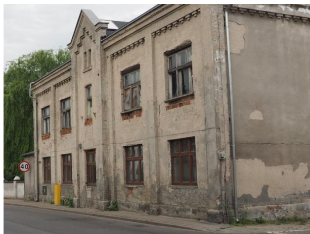
Zdjęcie 2. Budynek przy ul. Szkolnej w Łasinie
