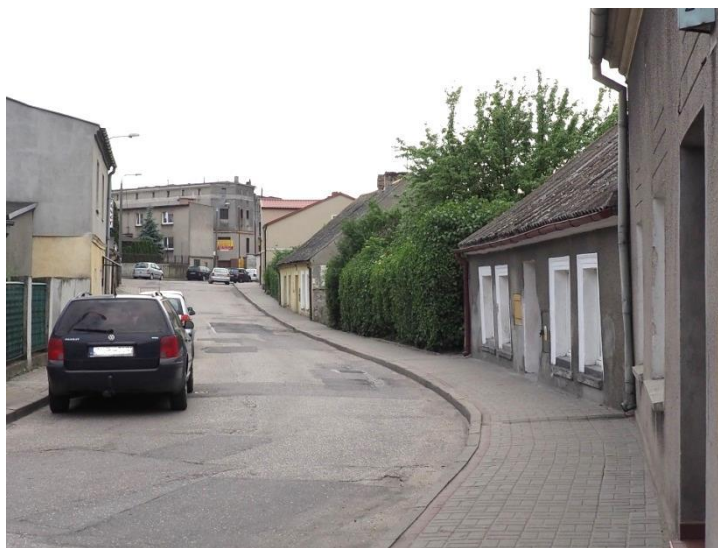
Zdjęcie 1. Przykładowe drogi wymagające modernizacji – ul. Podmurna
