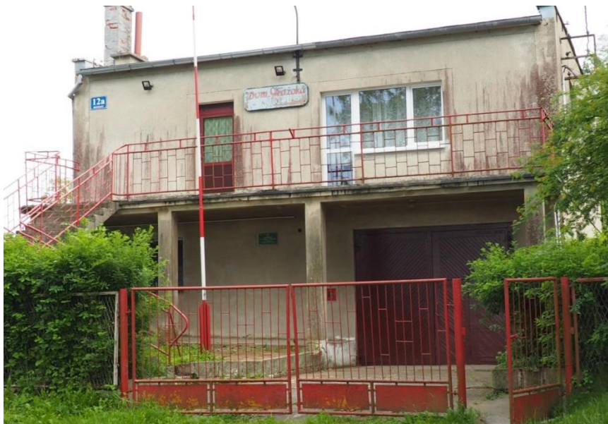
Zdjęcie 3. Świetlica wiejska w Nogacie
