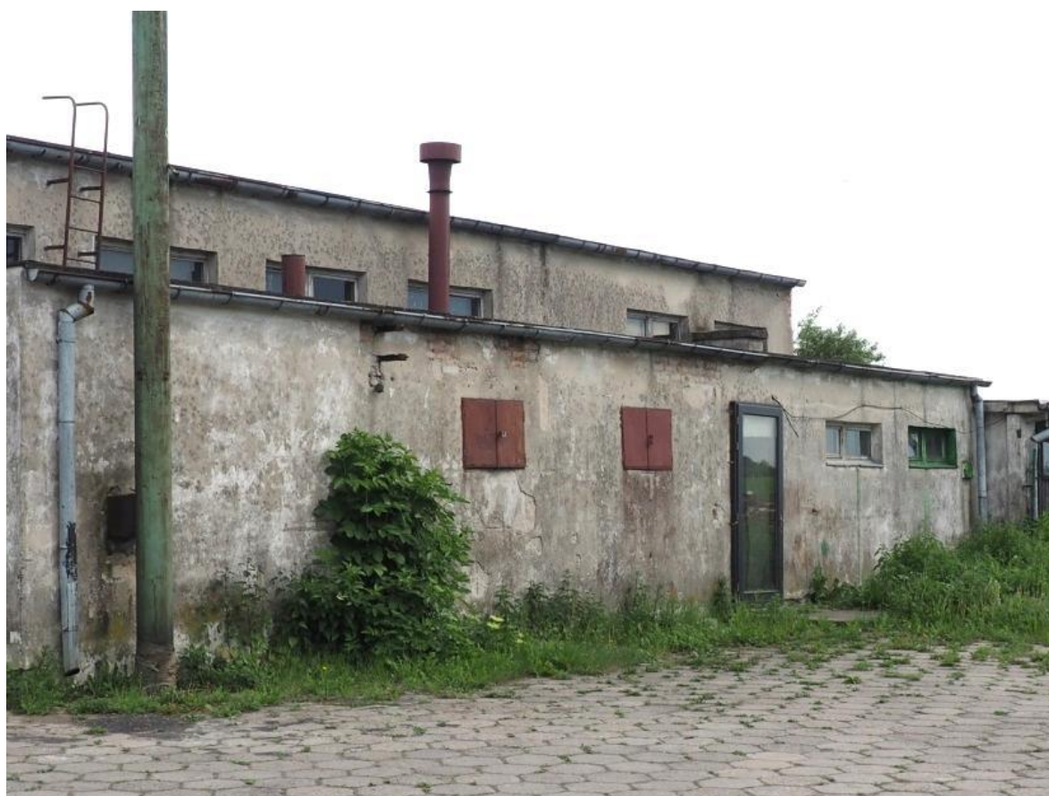
Zdjęcie 5. Przestrzeń zdegradowana – budynek po kotłowni osiedlowej
