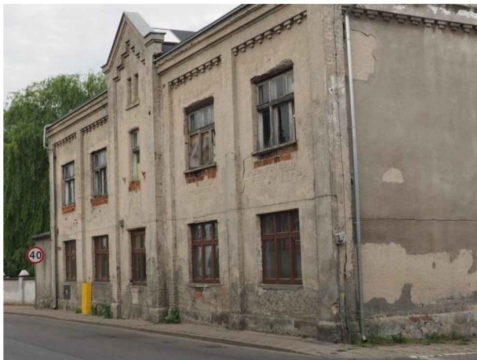
Zdjęcie 2. Budynek przy ul. Szkolnej w Łasinie
