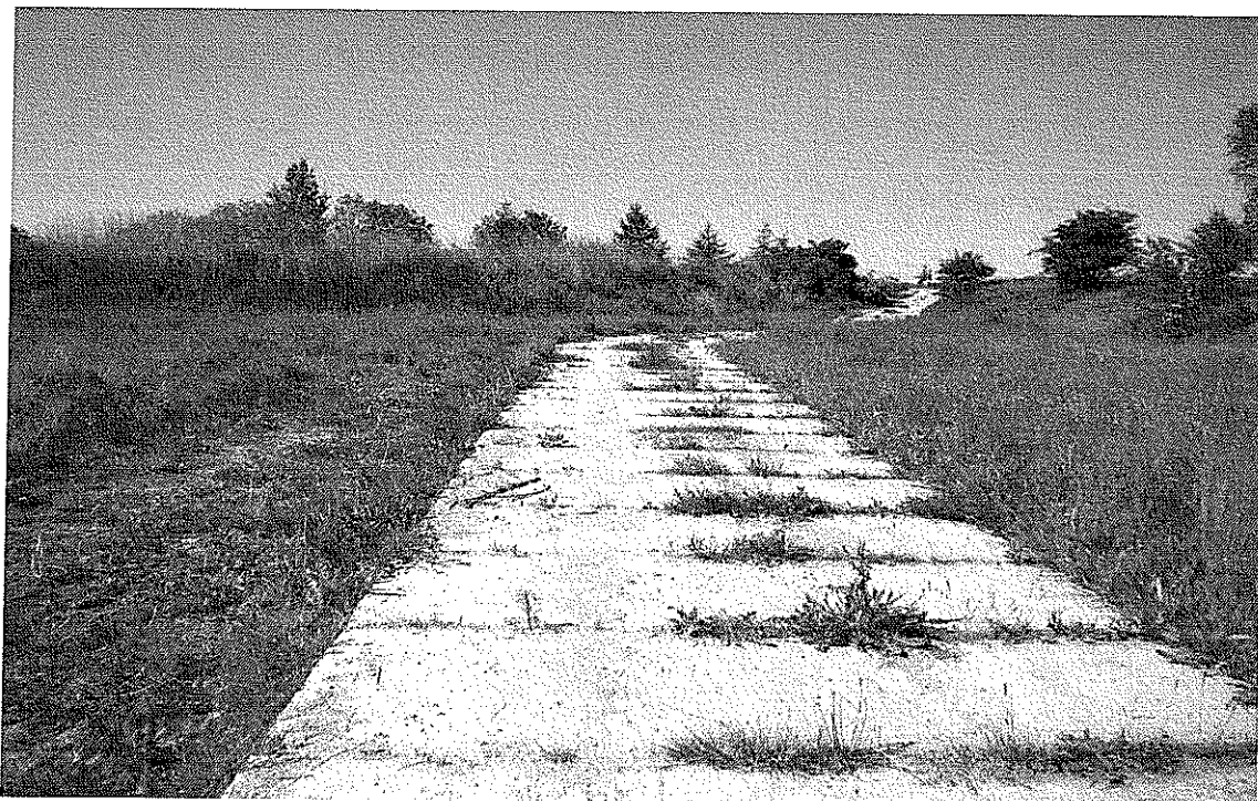
Zdjęcie nr 4. Istniejąca droga technologiczna z widocznymi skarpami docelowo przeznaczonymi
