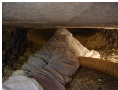
Operator pod stropem rozprowadza granulat
