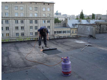
Uzupełnienie papy termozgrzewalnej
