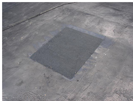
Zamknięty otwór po wykonaniu ocieplenia
