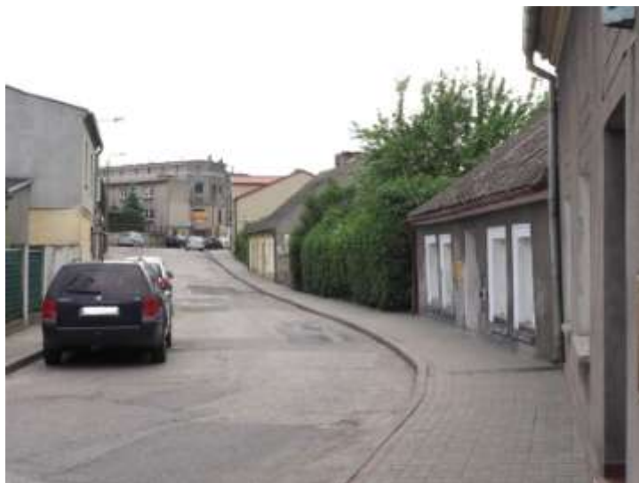
Zdjęcie 1. Przykładowe drogi wymagające modernizacji – ul. Podmurna
