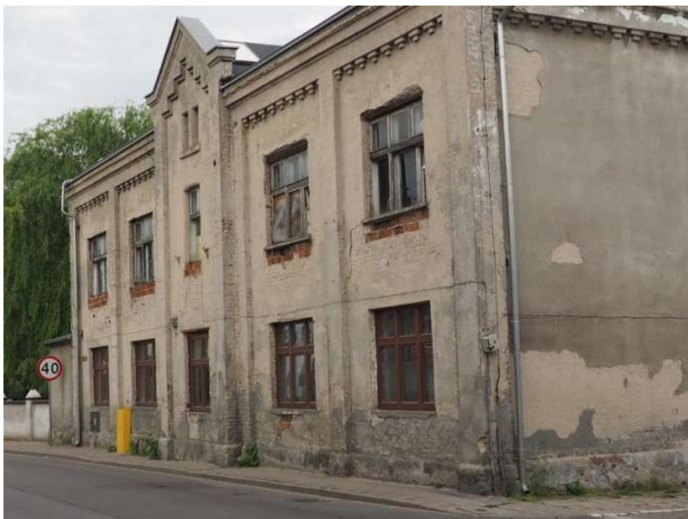
Zdjęcie 2. Budynek przy ul. Szkolnej w Łasinie
